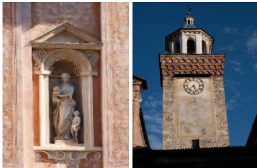
Campanile e un particolare della facciata della "Rossa".
